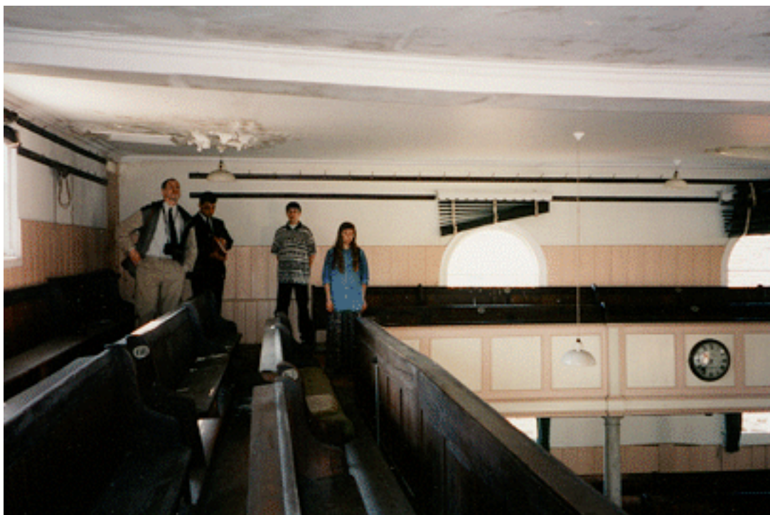
Het plafond wordt aan een inspectie onderworpen.
